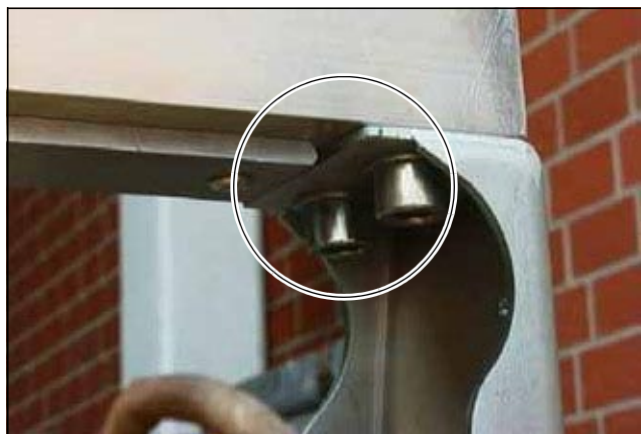
Рис. 5.22 Крепежные винты направляющей шины (показаны снизу)
